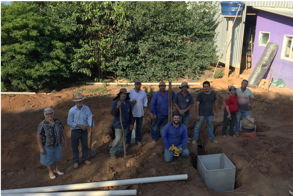
Figura 8 - Instalação do sistema de tratamento de esgoto no Sítio Seriema. Fonte: acervo FAFCoffeees
