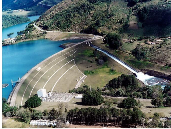
Figura 4- Usina Hidrelétrica de Caconde
